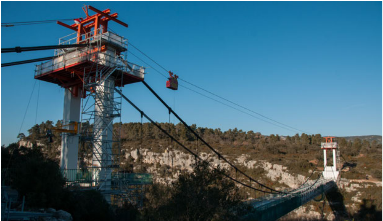
Vue d'ensemble du chantier
