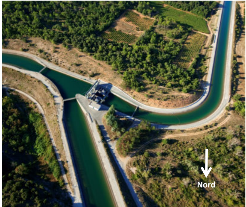
Prise de Boutre : à gauche le Canal mixte EDF/SCP, à droite le départ du Canal de Provence, en bas le Canal EDF.
