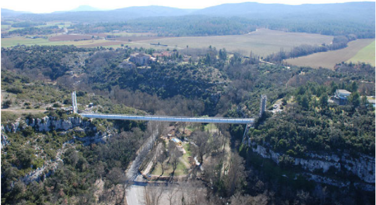
L'aqueduc dans son environnement avec la RD561 qui passe en dessous
