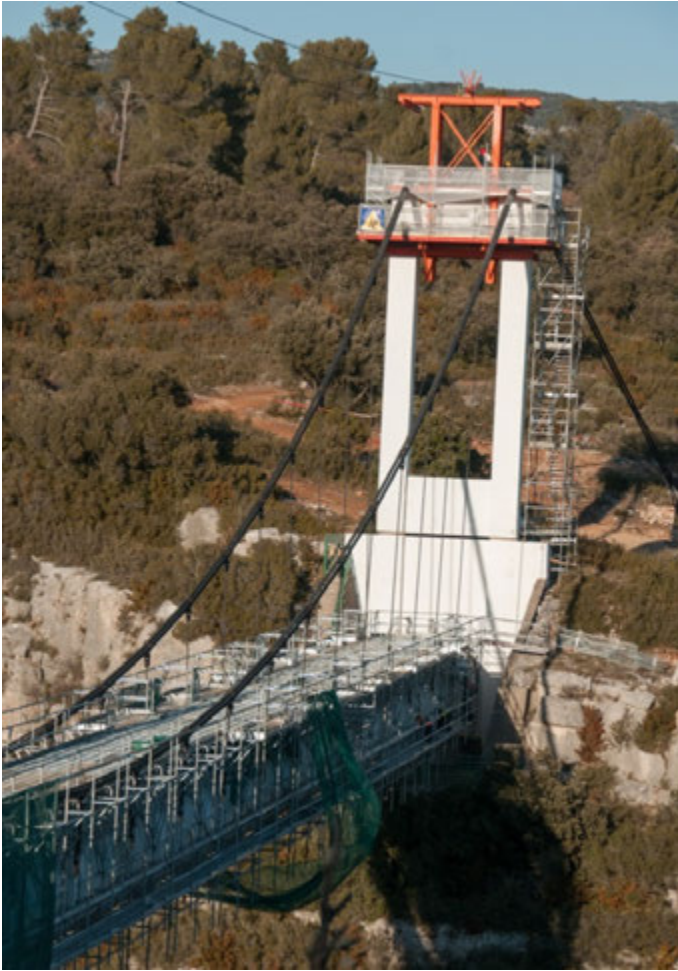
Installation des échafaudages sur la conduite et les pylônes
