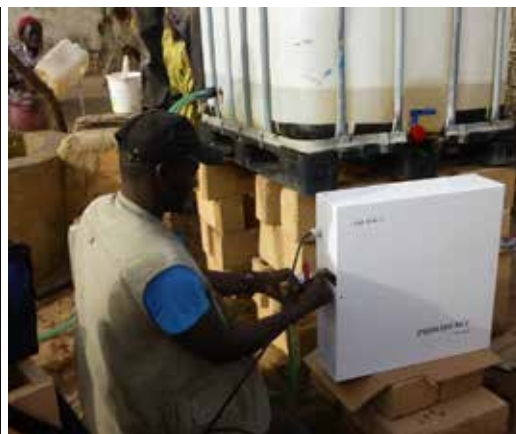
Installation de Providence dans un village du Sénégal
