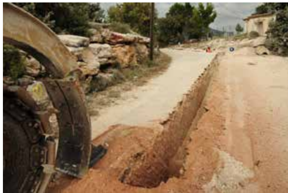
Travaux de tranchée en vue de l'installation de canalisations
