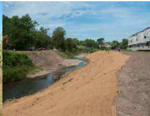
Génie végétal sur les berges du Riou de l'Argentière, Assistance à maîtrise d'ouvrage pour restaurer les milieux aquatiques, commune de Mandelieu-la-Napoule, Communauté d'agglomération Cannes et Pays de Lérins
