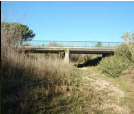
Lit de la Garde à sec en été, maîtrise d'œuvre pour la restauration du cours d'eau, communauté de communes du Golf de Saint Tropez
