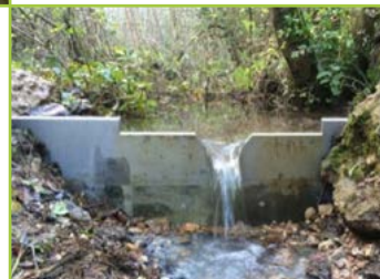
INSTALLATION D'UN SEUIL DE CALIBRE
